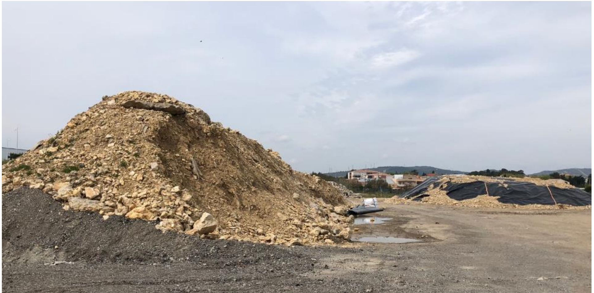
Figure 6 : stockage de terres inertes (à droite) stockage de terre non inertes (à gauche) (Source : Eiffage)
